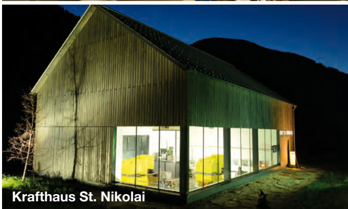
Pelton turbine Kraftwerk St. Nikolai
