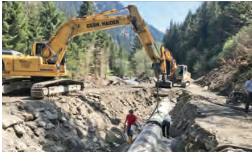
Lückenschluss der Druckrohrleitung Seifriedbach – über 2100 Meter wurden im großen Sölkthal neu verlegt.
