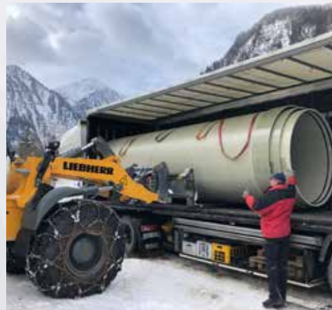
Lieferung der Rohre: 190 cm, 180 cm, 170 cm Durchmesser
