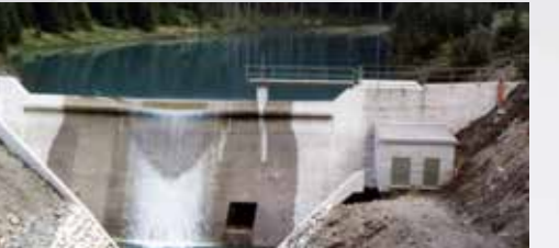
Kraftwerk Pruggern Oberstufe
