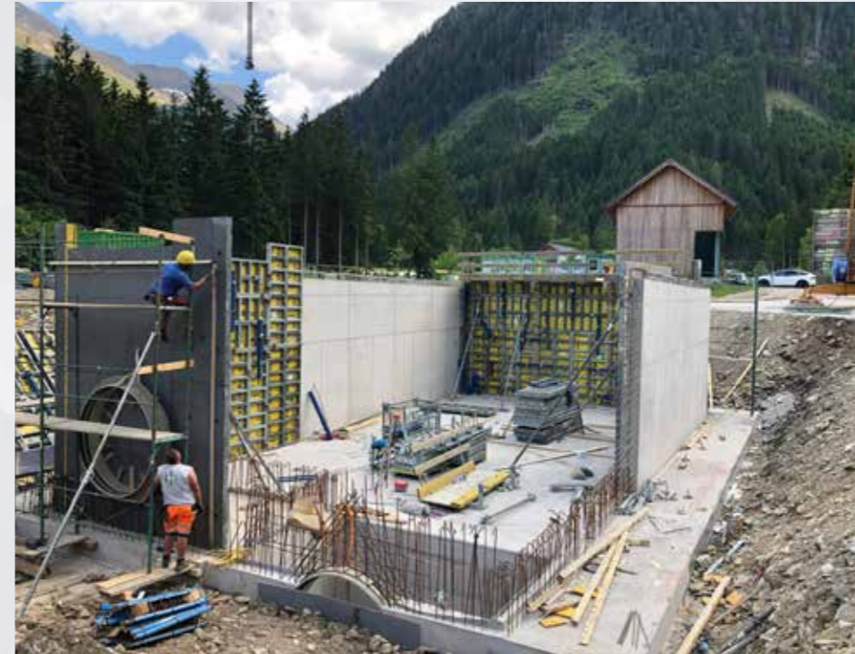
Das Sammelbecken wird herausgeschalt
