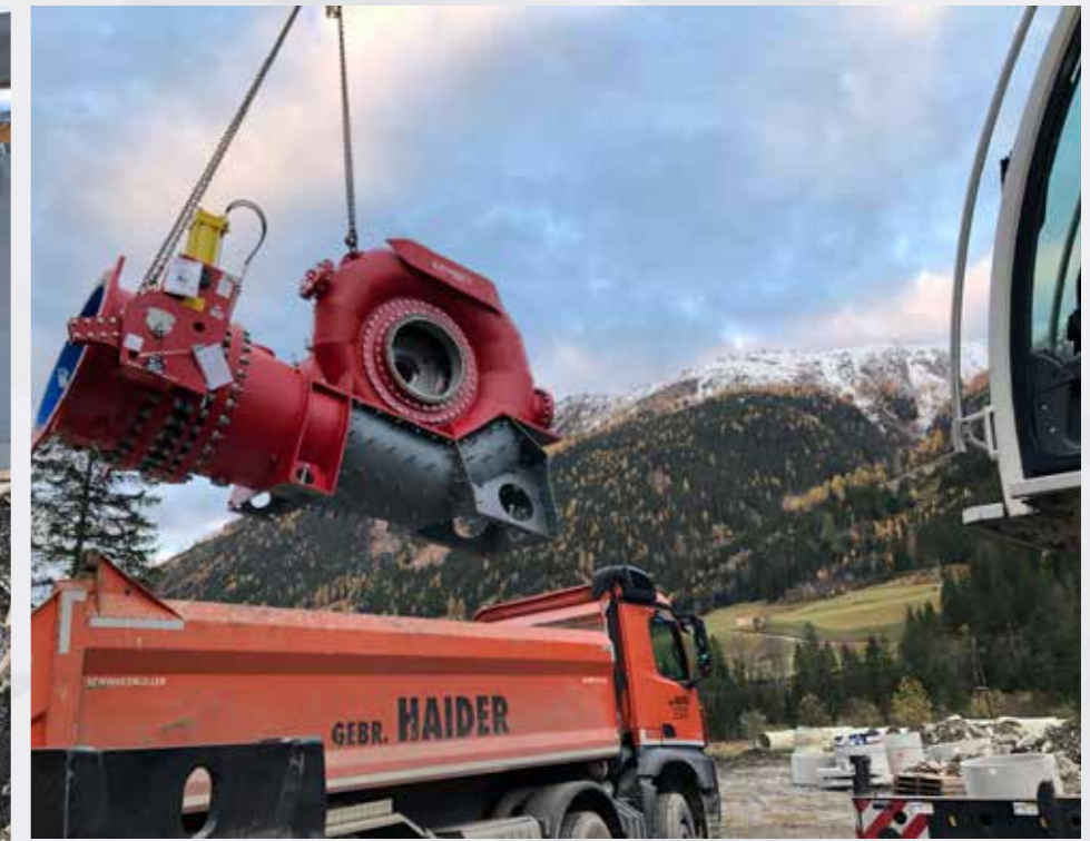
Verladung einer acht Tonnen schweren Francis-Turbine
