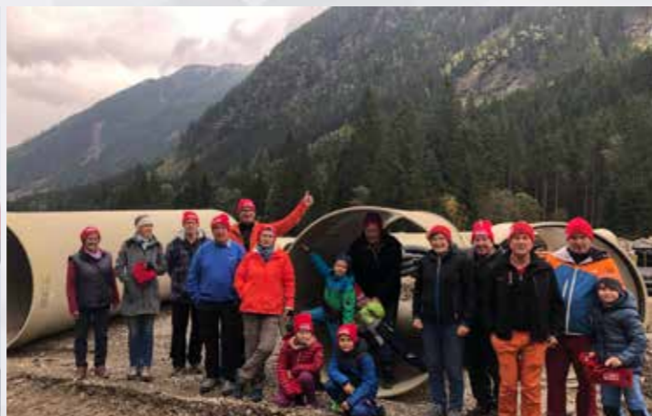
Exkursion zu unseren Kraftwerks-Baustellen
