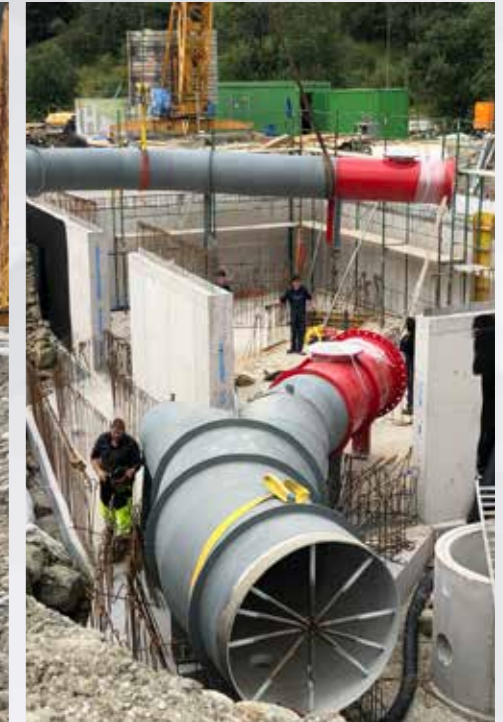
Im noch offenen Krafthaus wird das „Hosenrohr“ eingebaut
