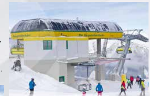
Planai-Bahnen diverse Installationen
