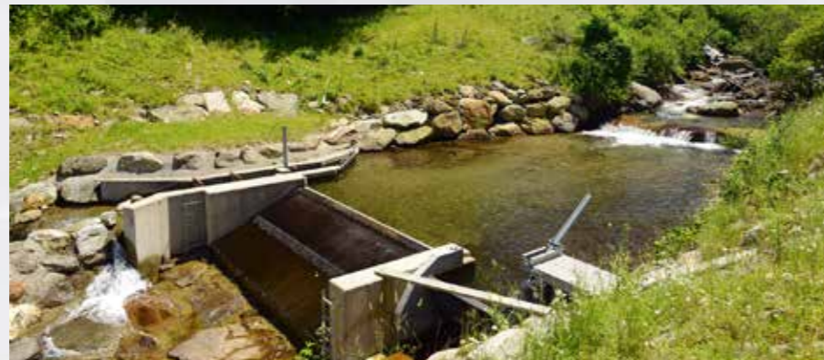
Beispiel einer in die Natur integrierten Tirolerwehr-Anlage.
