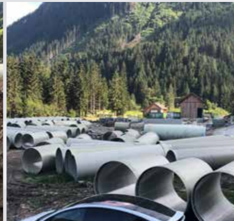
Die GFK-Rohre am Lagerplatz – 3400 Meter insgesamt
