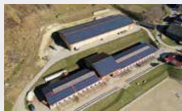
Reitsportarena Schlad., 350 kWp
