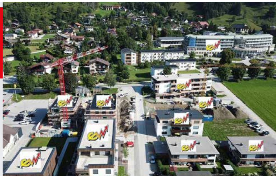
Das „E-Werk Eck“ in Gröbming – realisierte Baustellen in letzter Zeit
