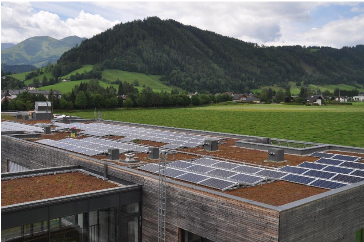
Bildtext: Der westliche Teile der Anlage in Bau Fotocredit: E-Werk Gröbming, Abdruck honorarfrei.
