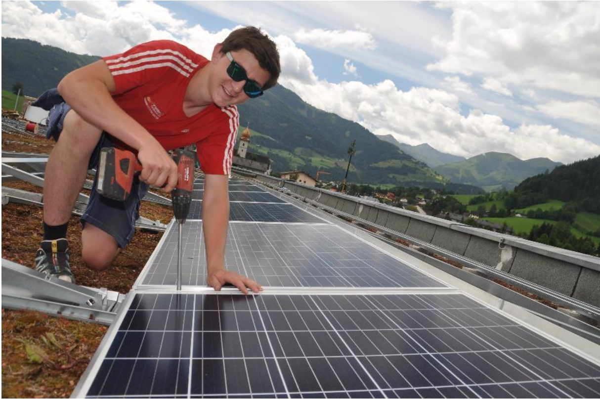
Bildtext: 450 solcher 160cm langen Module wurden angebracht Fotocredit: E-Werk Gröbming, Abdruck honorarfrei.
